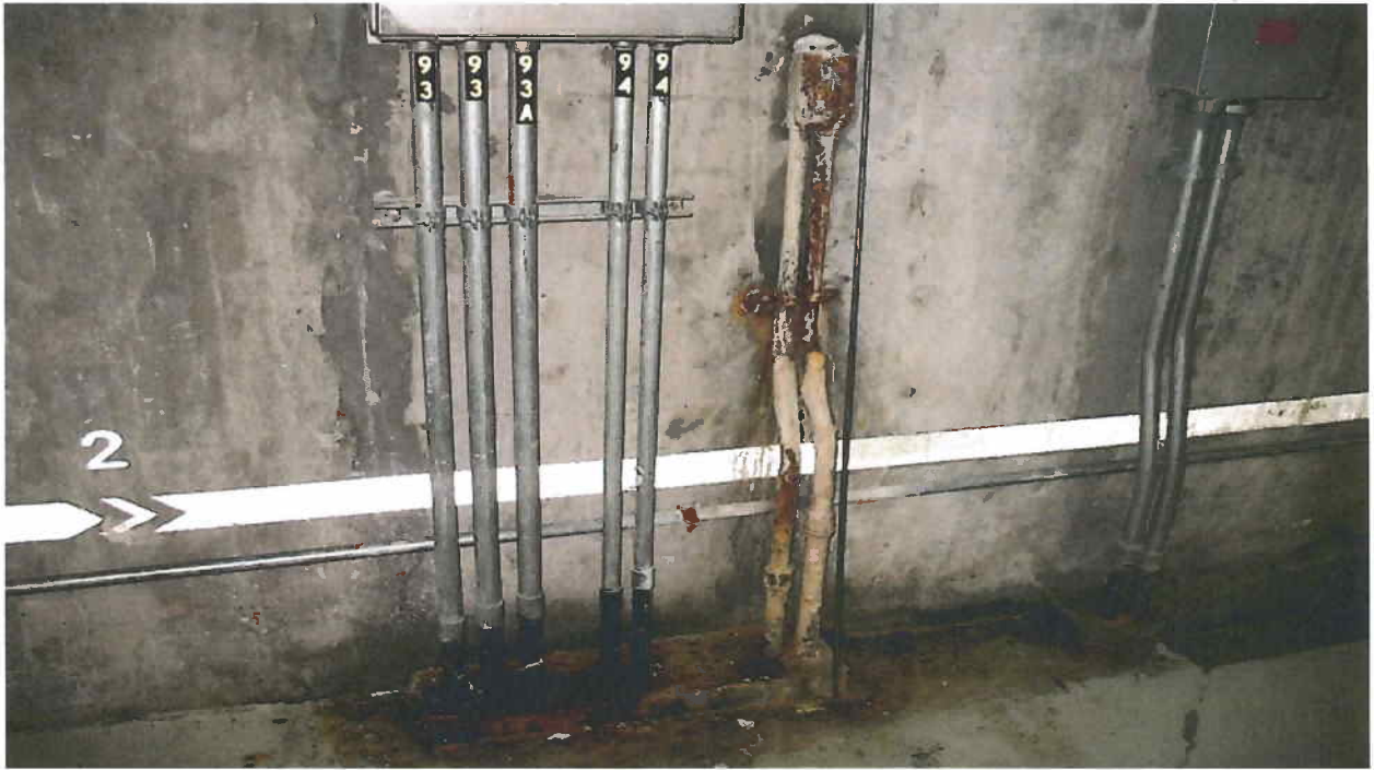
Corroded Conduits
