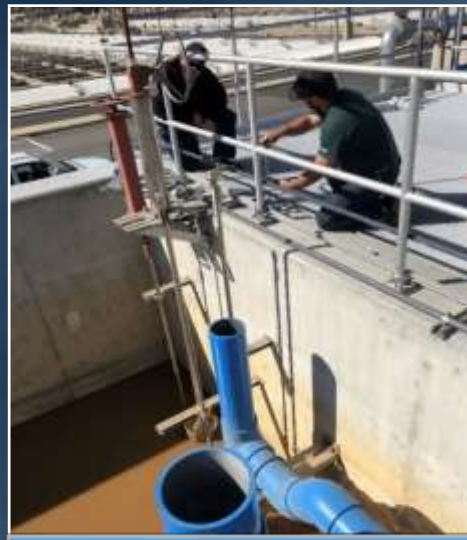
New Conduit Routing
